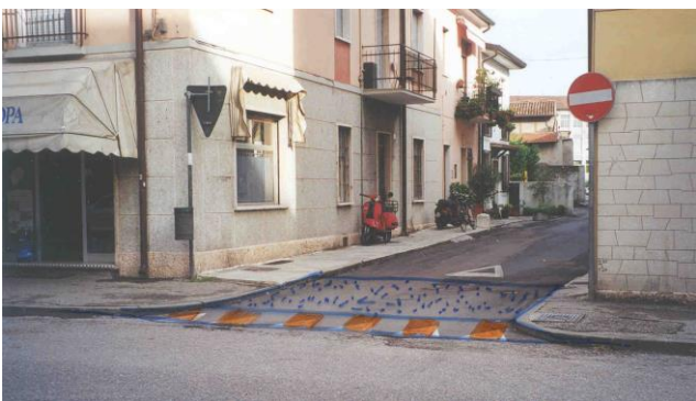
Precedenza al pedone e uscita rallentata mediante la continuità del marciapiede
