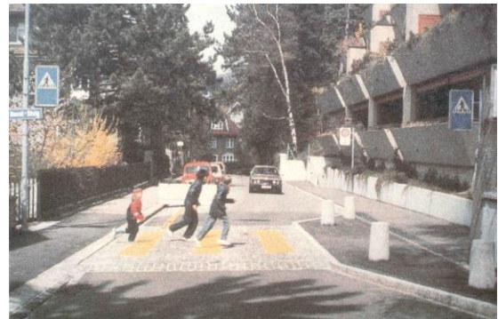
Attraversamento pedonale ristretto e su piattaforma rialzata in prossimità di una scuola
