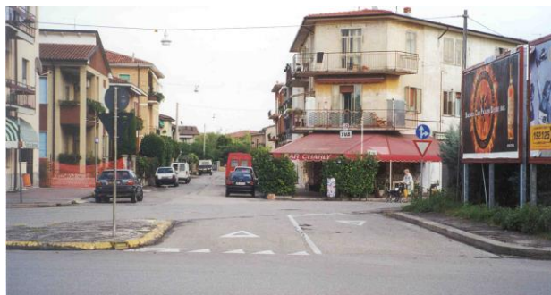
Caso 3: Progetto di accesso rallentato mediante la continuità del marciapiede e l'inserimento di verde
