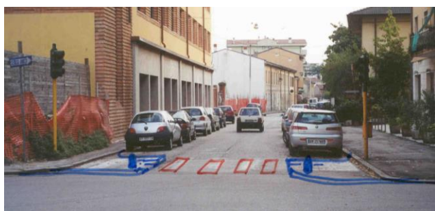
Caso 1a) - La presenza permanente di auto in sosta impone di avanzare il marciapiede da entrambi i lati
