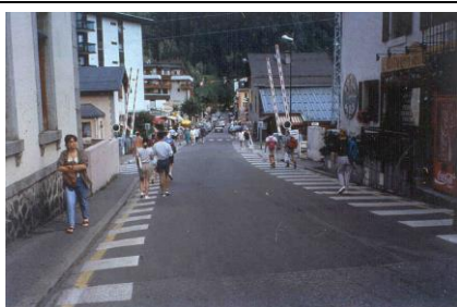
allargamento del marciapiede con segnaletica orizzontale
