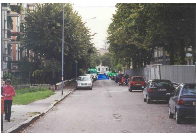
Nella strada troppo uguale solo il cambio ed il rialzo della pavimentazione possono indurre attenzione al conducente
