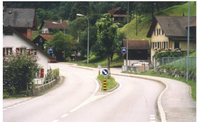
Svizzera - rallentamento all'ingresso di un centro
