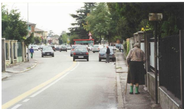
Il marciapiede è di larghezza insufficiente da entrambi i lati della strada che conduce alla scuola
