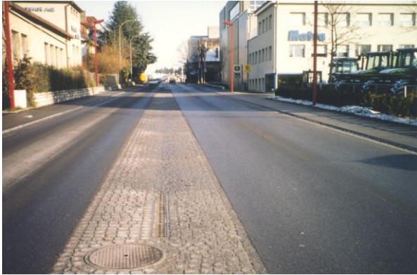
Svizzera, Zollikofen - corsia centrale semicarreggiabile su strada urbana utile per attraversamenti pedonali diffusi o proteggere la svolta a sinistra
