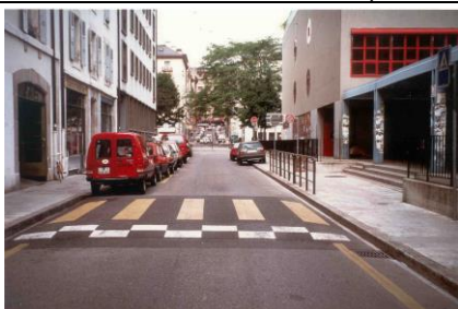
attraversamento rialzato in bitume
